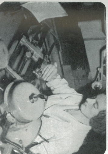
Wikkelen ontstekingspoel. De spoel is een der moeilijkst te vervaardigen onderdelen van de gehele motor. Deze wikkelaarster is doende de primaire wikkeling (dikke draad) te leggen om het zogenaamde statopakket.
